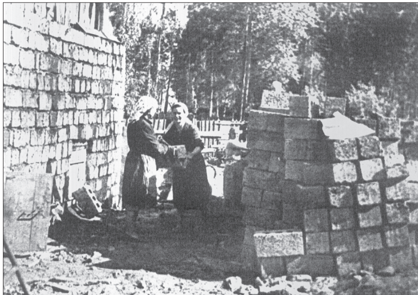
Уздания изготовления шлакоблочных кирпичей. Готовая продукция складывается в штабеля
