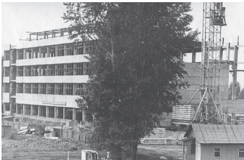
Строительство корпуса ЭНИС. 1976 год
