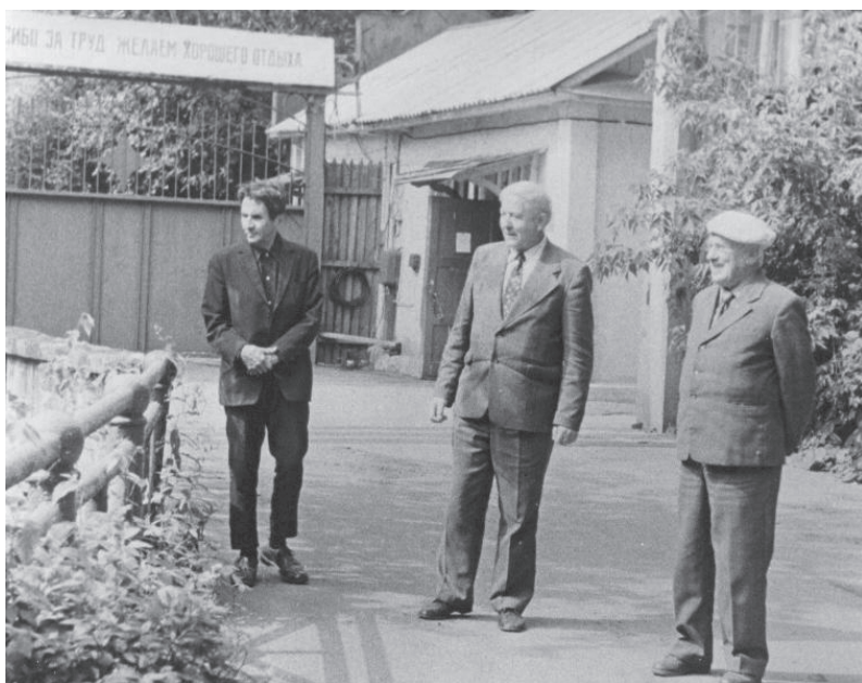
И.Р. Классон, Н.И. Устин, П.Г. Грудинский у второй проходной электростанции. Стоят на мостике через сбросной канал циркуляционной воды. 1978 г.
