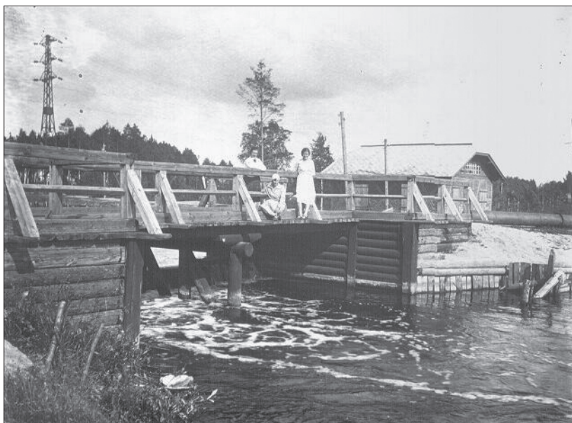
Место постоянного поста. На переднем плане проток воды из озера №4 в приемный водоем. Сзади насосная подкачки воды из озера
