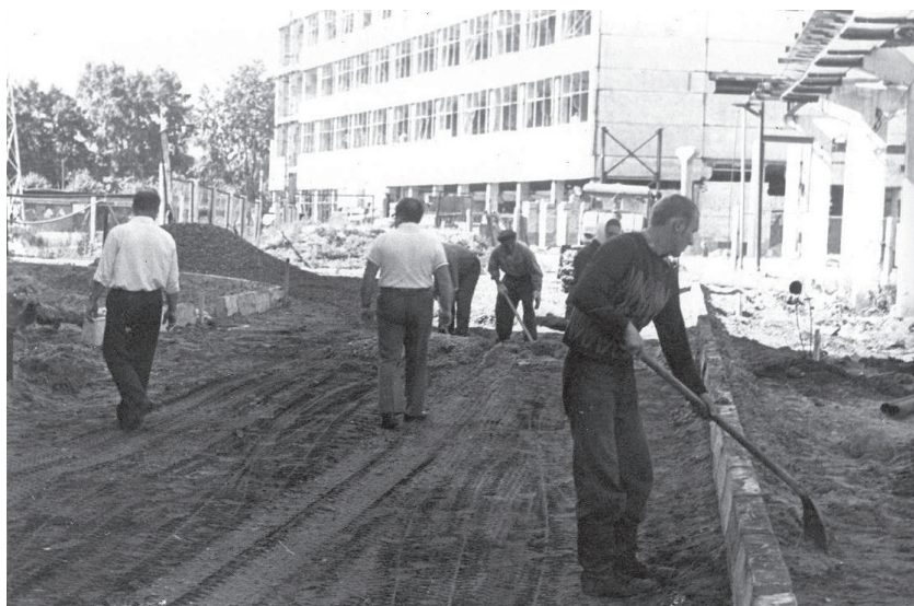
Асфальтирование дороги у торцевой стены главного корпуса со стороны турбины № 1. На заднем плане строящийся корпус ЭНИС
