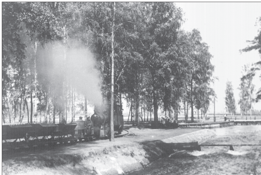
Вывозка золы с электростанции для сооружения дамбы по перекрытию скворцовских буферных водоемов. 1953–1954 гг.
