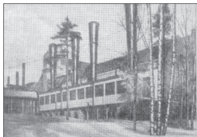
Вид станции со стороны подачи торфа. На переднем плане котельная №2, где установлены котлы №№ 16, 17, 18, 19. 1927 год
