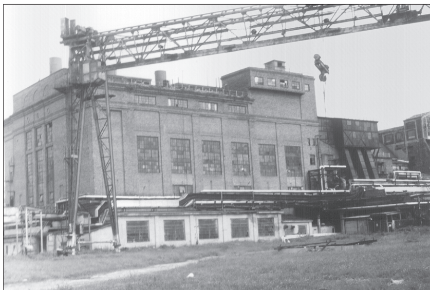
Пристройка котельной №3, в которой были смонтированы котлы высокого давления
