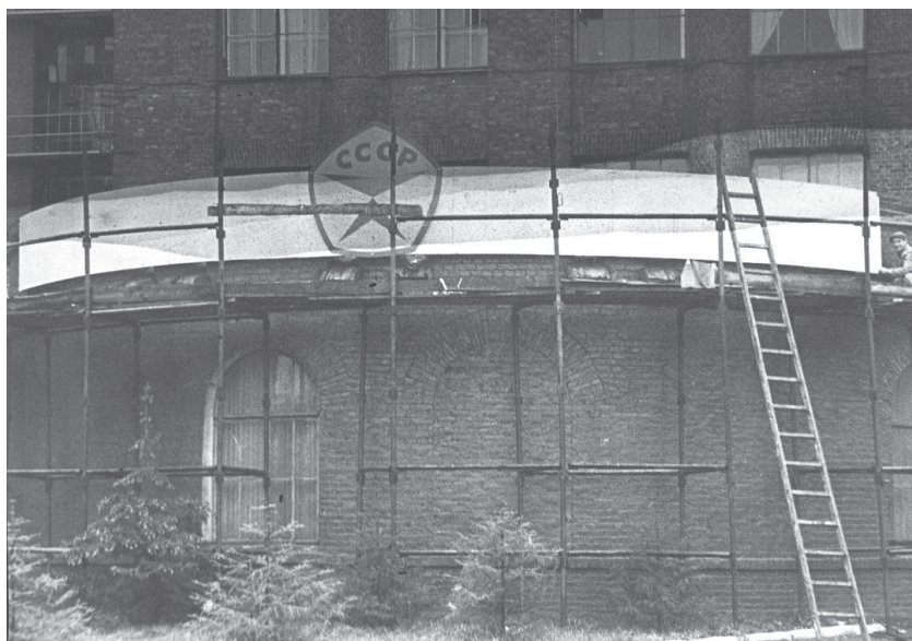
Оформление полукруглой части административного здания электростанции
