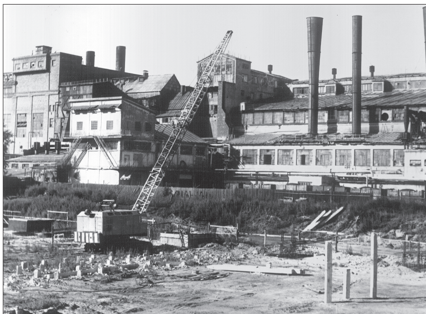
Состояние строительной площадки главного корпуса пиковой газотурбинной электростанции. Конец 1975 года
